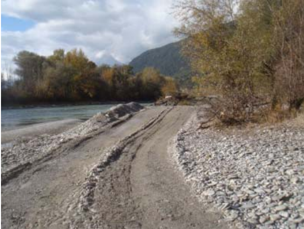
Bild 1: Baustellenzufahrt für die Revitalisierungsmaßnahmen in der Dirschenbach-Au Quelle: Mag. Traute Scheiber, ITS Scheiber
